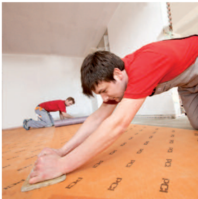
Položiť PCI Pecilastic® U a pevne pritlačiť, napr. drevenou latou alebo hladidlom z tvrdenej peny.
