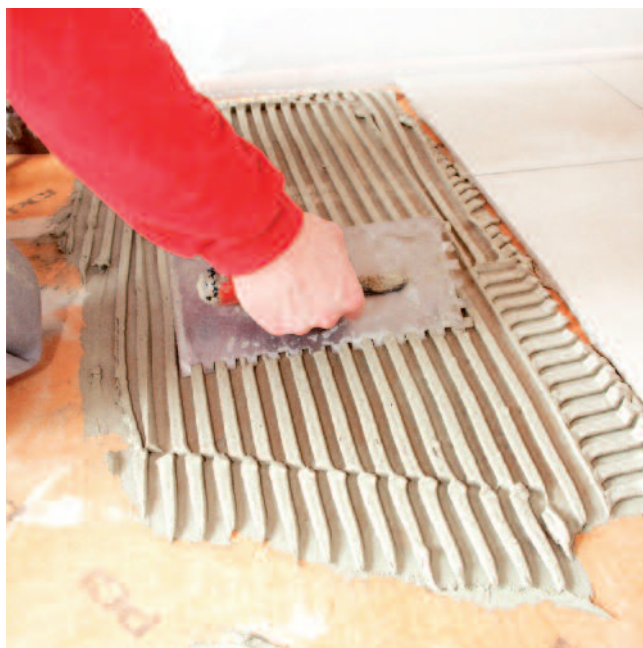
... a do PCI Nanflott® light alebo PCI Rapidflott® položiť novú keramickú dlažbu.
